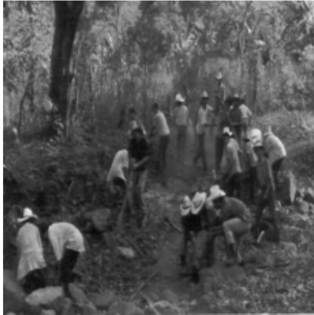
Construcción vial en Pompoa, Santa Bárbara
